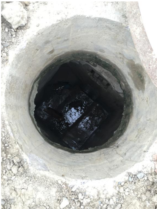
北侧污水接管口
