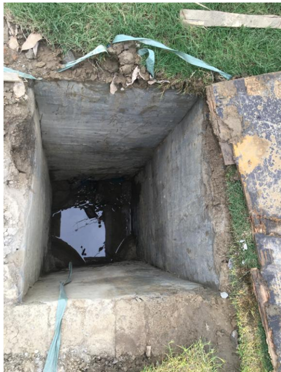
南侧污水接管口
