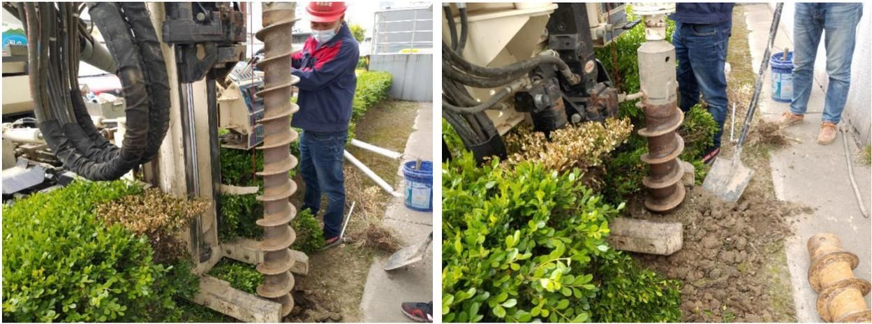
图 6-5 地下水监测井建井钻孔
