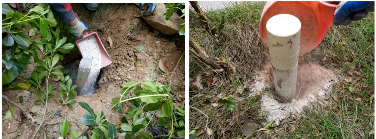
图 6-6 填充石英砂作为滤水层（左）和填充膨润土封孔（右）
