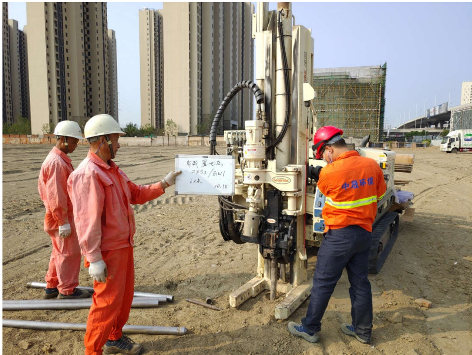
图 4-3 机械钻孔取土片
