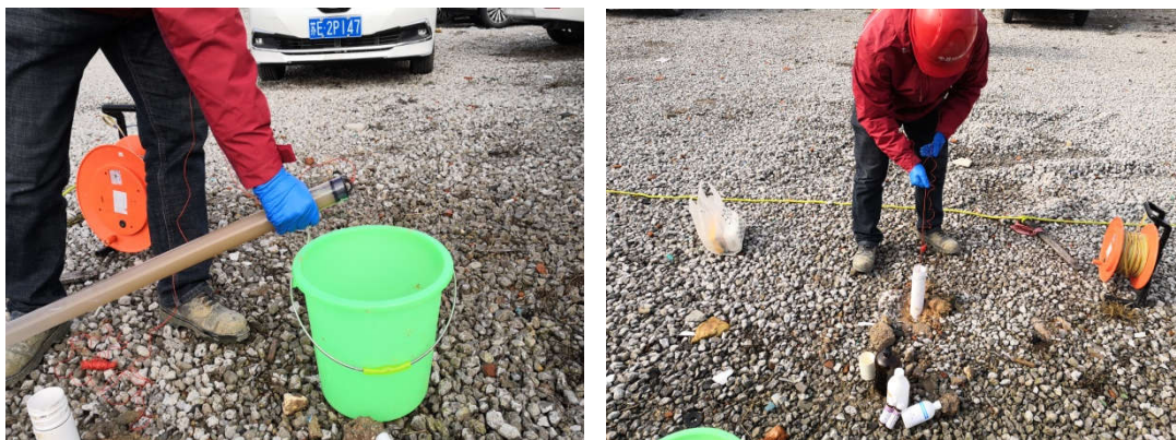
图 4-9 地下水监测井成井洗井（左）和采样前洗井（右）
