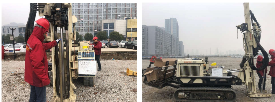
图 4-5 下钻过程（左）和拔出取土管（右）
