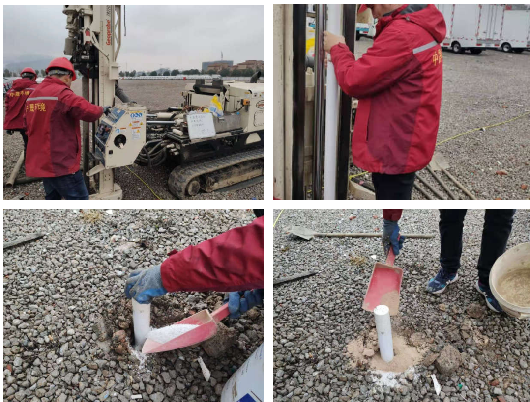
图 4-8 地下水监测井钻孔、安装井管、填充石英砂和填充膨润土现场照片
