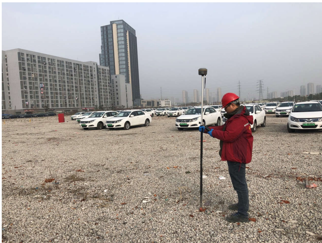
图 4-1 南方（South）“银河 1”RTK 测量系统及现场操作图
