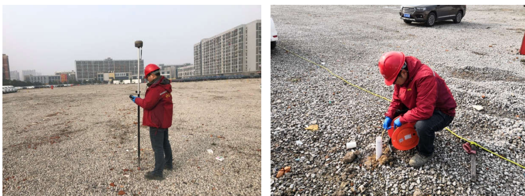
图 4-10 点位标高测量（左）和地下水水位测量（右）
