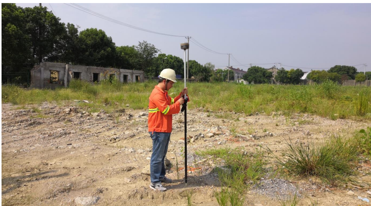
图 5-1 南方（South）“银河 1”RTK 测量系统及现场操作图
