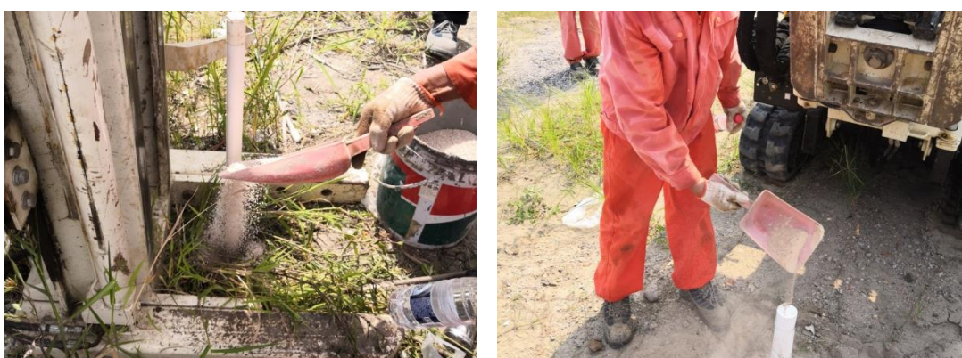
图 5-5 回填石英砂作为地下水滤层（左）和回填膨润土封孔（右）
