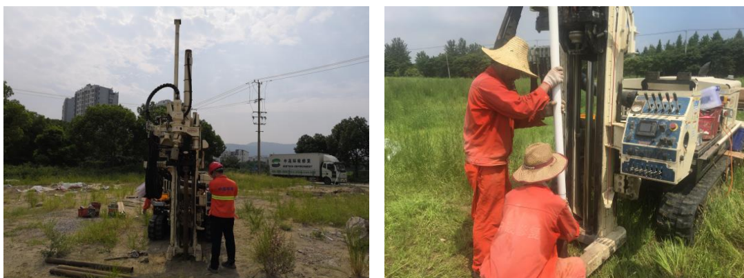
图 5-4 Geoprobe 直推螺旋钻探（左）和放地下水管（右）
