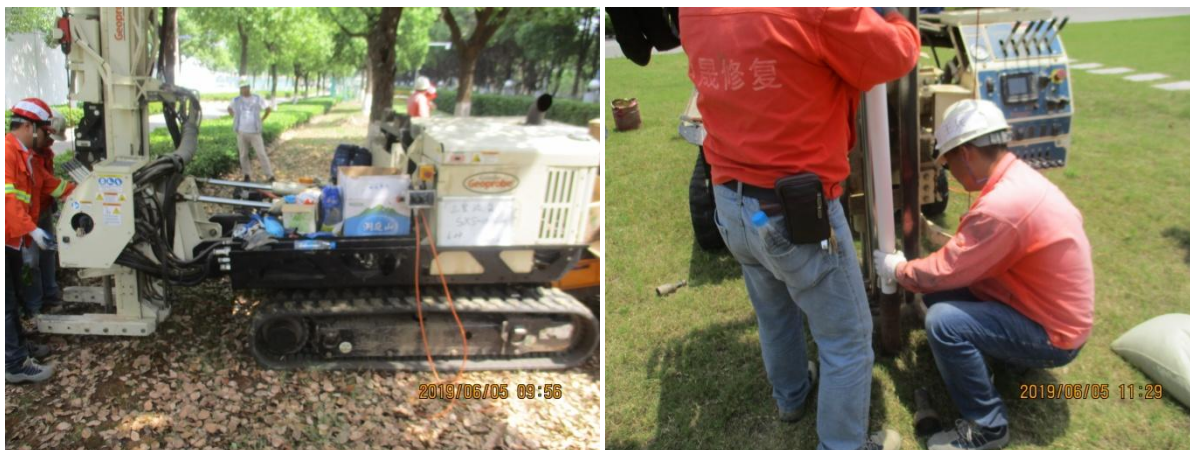
图 5-7 地下水监测井建井钻孔（左）和安装井管（右）
