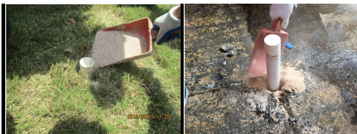
图 5-8 填充石英砂作为滤水层（左）和填充膨润土封孔（右）
